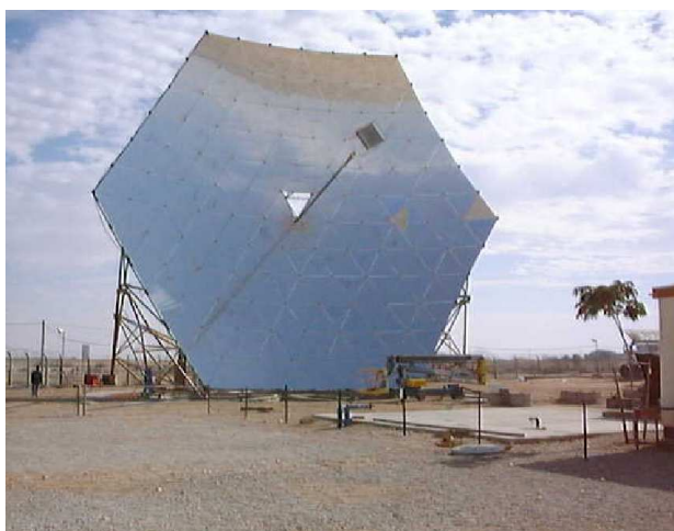
Рис. 7: Солнечный концентратор PETAL .
