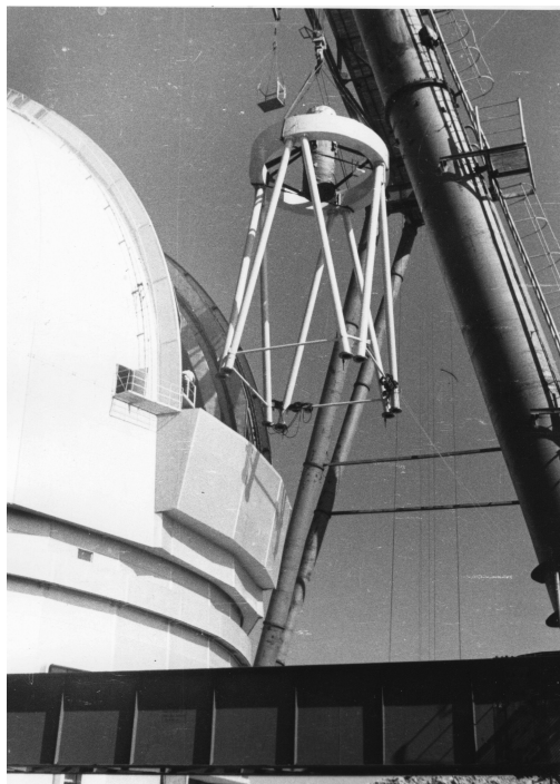
Монтаж телескопа: вид извне башни
